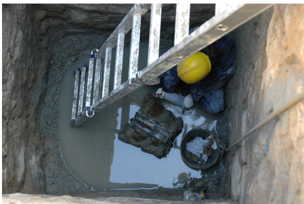
Figura 1. Portadora en procés d'extracció
